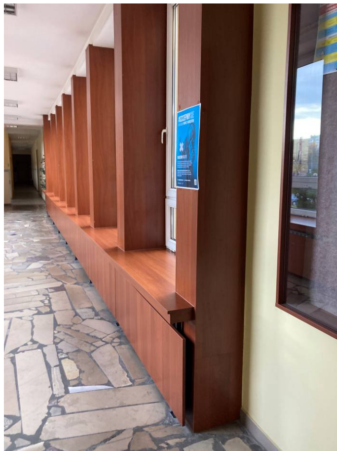
Drzwiczki rewizyjne do instalacji c.o.
