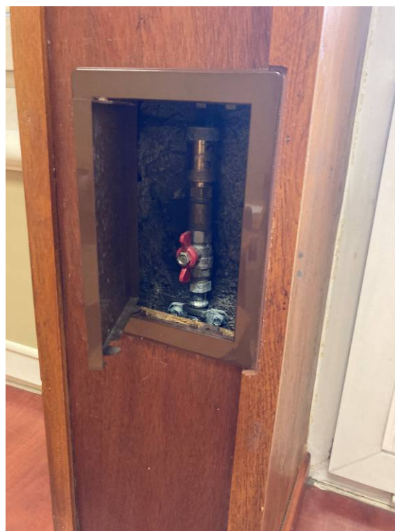
Drzwiczki rewizyjne do instalacji c.o.
